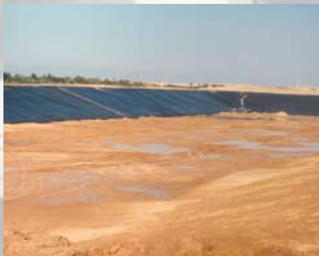
Λιμνοδεξαμενή συγκέντρωσης βρόχινου νερού.
