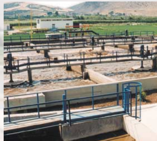
Μονάδα τριτοβάθμιας επεξεργασίας λιμμάτων πόλης Λιβαδειάς.
